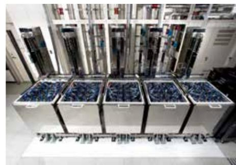
液浸槽5台による液浸冷却が大きな特徴
